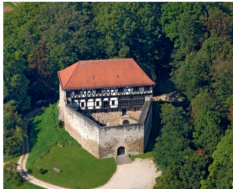
🏰 Zehn Meter hohe Mauern umschließen die Anlage, die als Vorwerk für den Stammsitz auf dem Hohenstaufen diente
